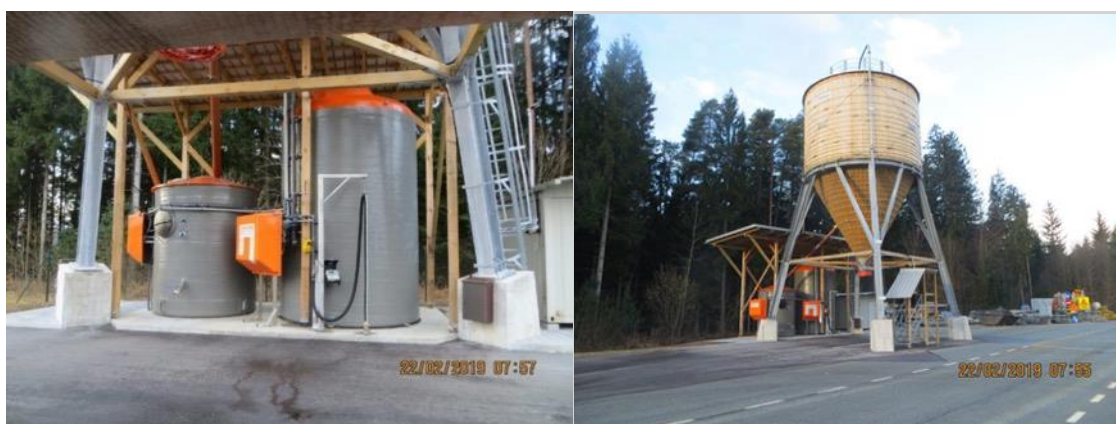
Slika 89: Nove avtomatizirane mešalne naprave
