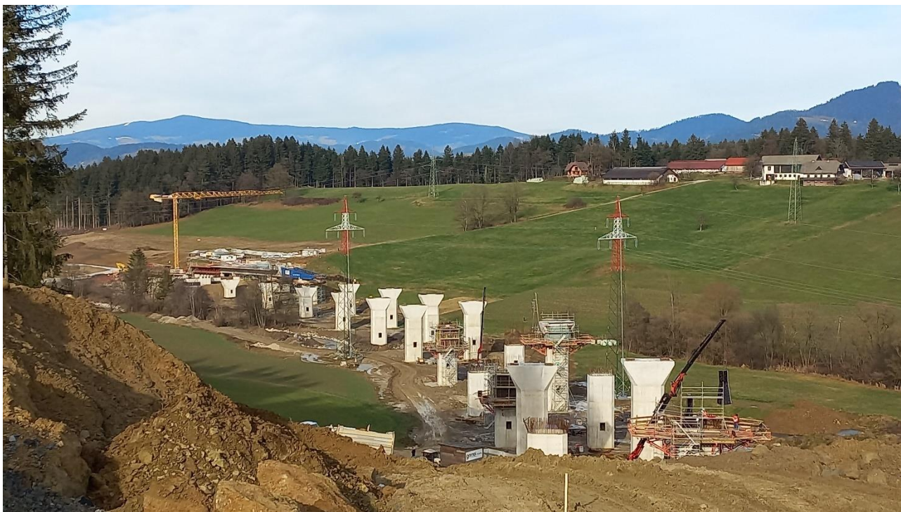
Slika 9: Pogled na gradbišče viadukta Jenina na sklopu F – Jenina
